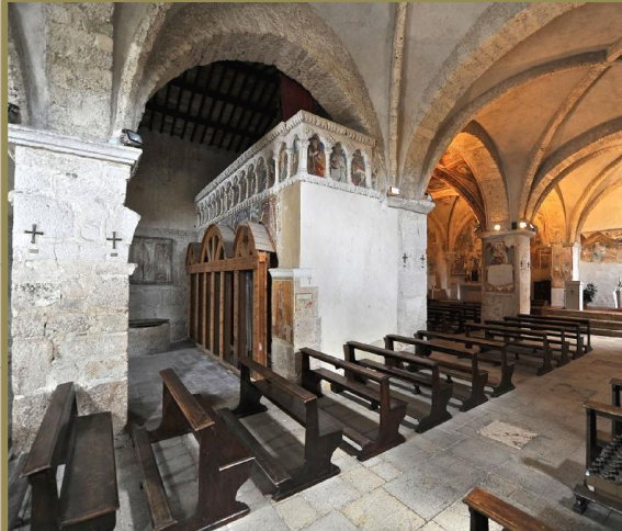
STATO DELL'OPERA PRE-SISMA
