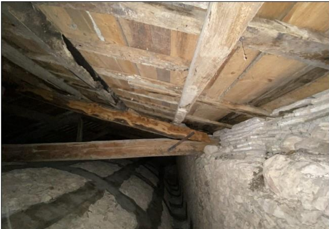
foto n.5 – Stato post sisma delle componenti lignee della struttura di copertura fonte: Progetto Esecutivo - TAV.F.02: Documentazione fotografica degli interni
